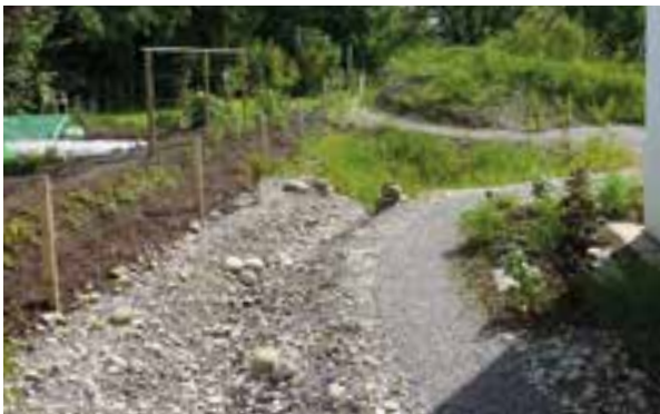
Regenwasserableitung entlang eines Weges in eine Feuchtmulde.
