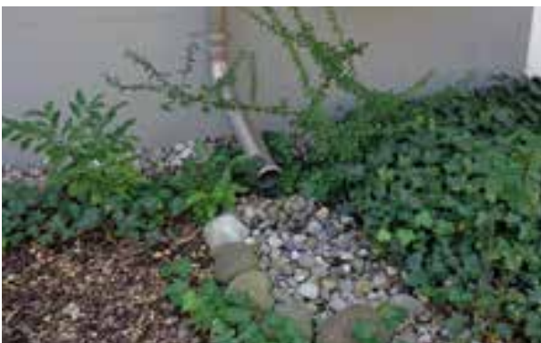
Versickerung des Regenwassers. Steine verhindern ein Wegschwemmen der Erde.
