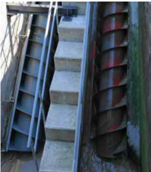
1 Hebewerk (Einlaufpumpe)
