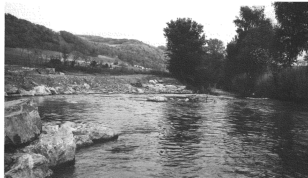
Renaturierter Gürbe-Abschnitt bei der ARA Kaufdorf
