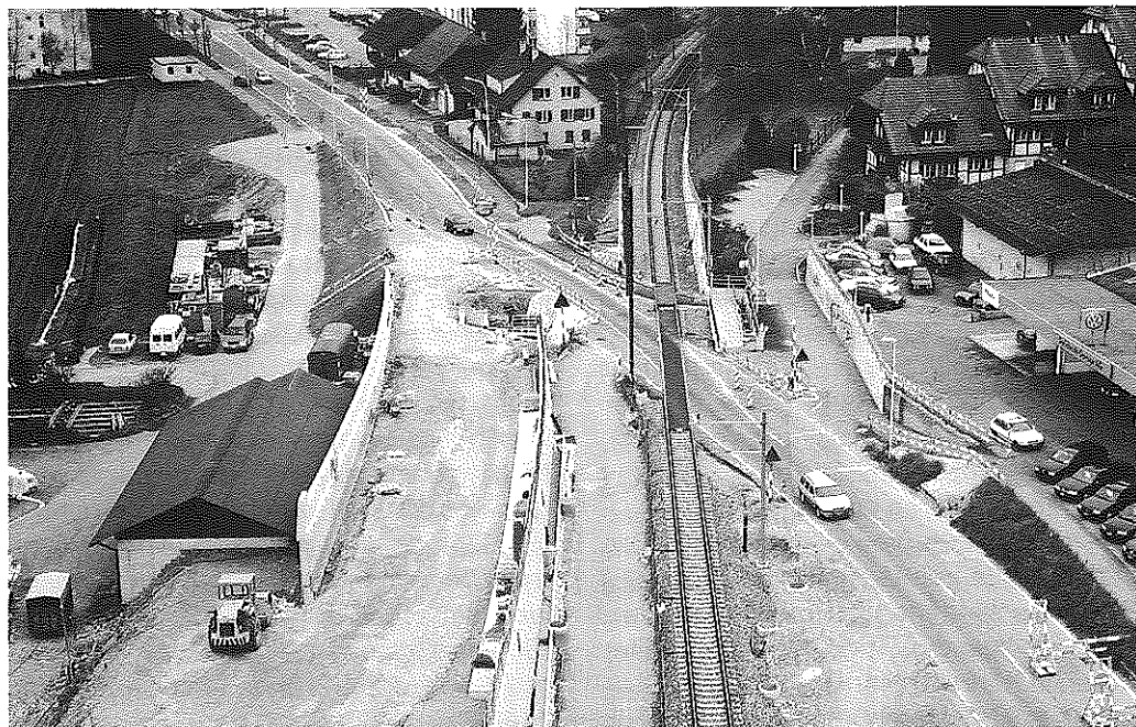
Ein aktuelles Bild aus dem Gürbetal: Die BLS ist sukzessive daran, die S-Bahn-Strecke Bern-Belp vollständig auf Doppelspur auszubauen. (Sicht aus dem Kran auf den Übergang bei Belp-Steinbach; in der Mitte unten gut erkennbar das vorbereitete Trasse für das zweite Gleis.)
