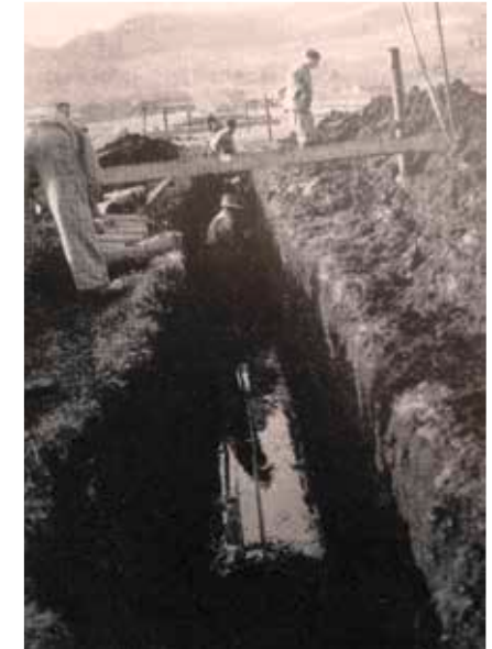
Ausgraben und Neuverlegen von alten Leitungen
